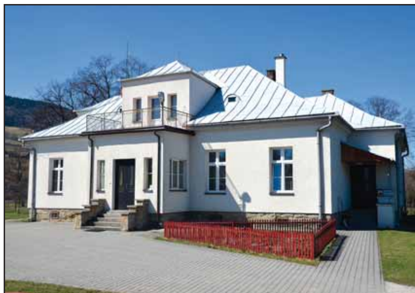
Nowa plebania w Ujanowicach
